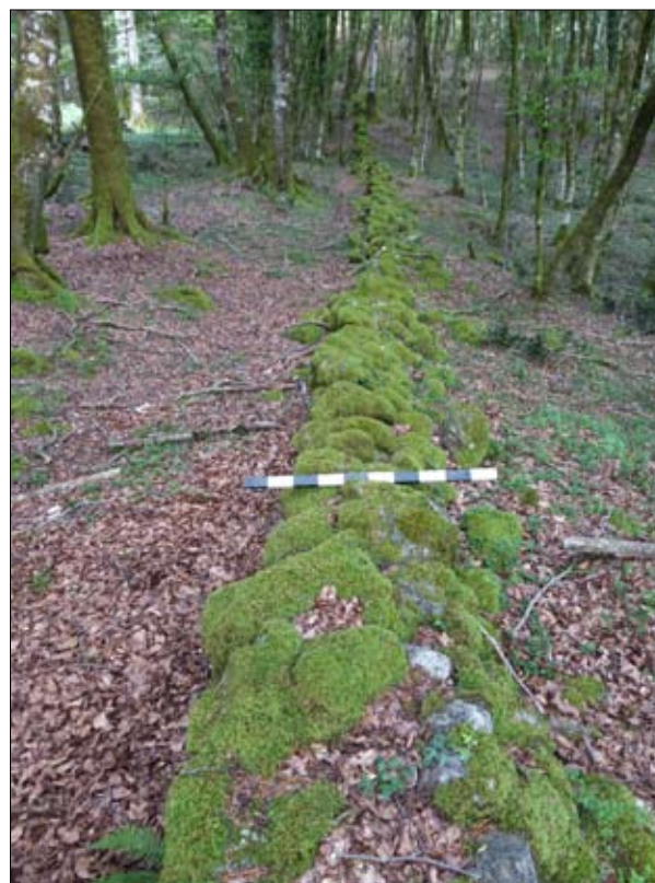
Fig. 4. La struttura muraria adiacente al Passo di Càncelo, vista da est (foto P. Visonà, giugno 2024).
