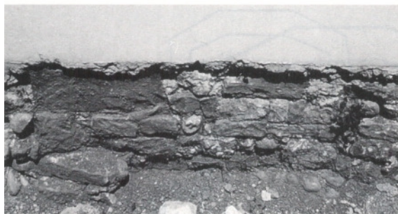
Figura 4. Chiesa di S. Maria di Castions di Strada. Particolare dell'apparato murario della navata centrale
