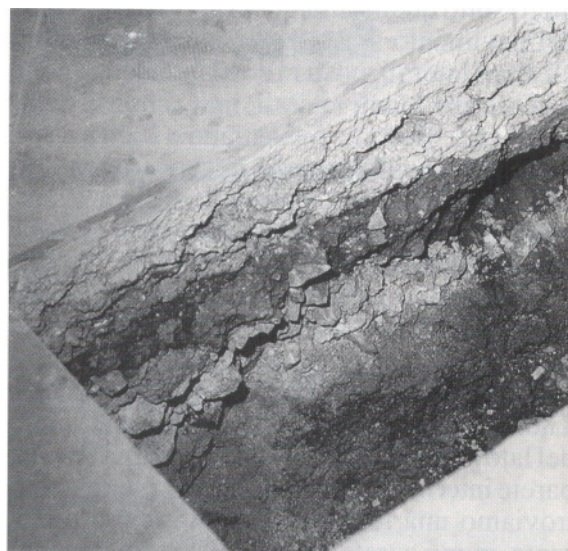
Figura 6. Chiesa di S. Maria di Castions di Strada. Particolare della pavimentazione in cocciopesto.
