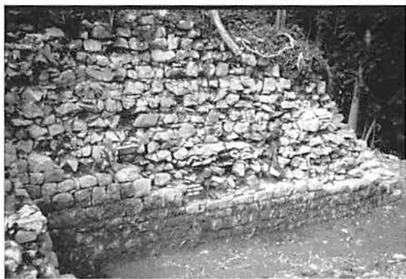
Fig. 4. Un tratto del muro perimetrale sud.
