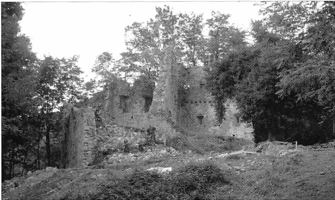
Fig. 1. Castello di Cergneu. Campagna 2001. Panoramica del castello di Cergneu visto da sud (foto SFA).
