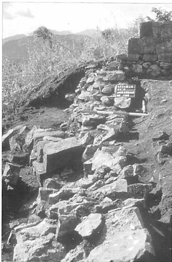
Fig. 4. Castello Superiore di Attimis. Il muro perimetrale US 104 della stanza "A".
