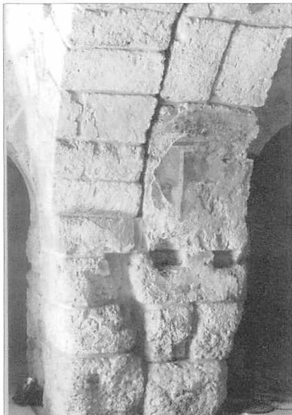
Fig. 11. 'San Pietro', aggiunta dell'arcata che sostiene le cupole, vista da sud / Baunaht der die Kuppeln tragenden Gurtbögen, Ansicht von Süden.
