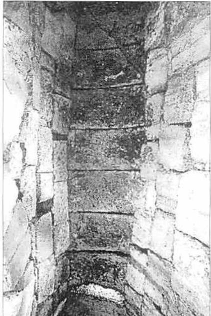
Fig. 29. 'San Pietro', navata meridionale, parte occidentale; copertura con lastre piane / südl. Seitenschiff – westlicher Bereich: Eindeckung mit Steinplatten (da / nach: MARUGGI, LAVERMICOCCA 1999, fig. 106).
