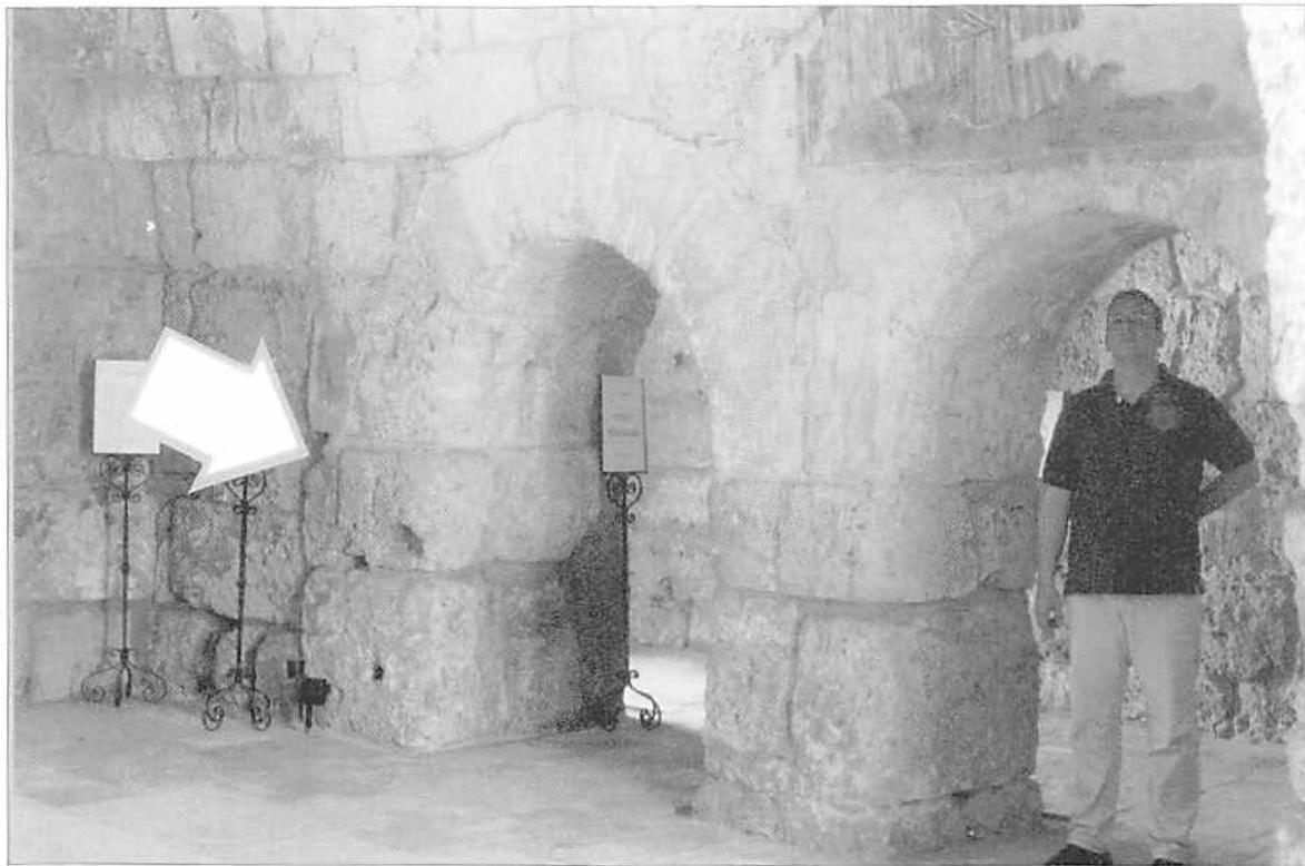
Fig. 13. 'San Pietro', arcata meridionale, parte orientale: vista da nord (freccia = parte aggiunta) / Südarkade – östlicher Bereich: Ansicht von Norden (Pfeil=Baunaht).
