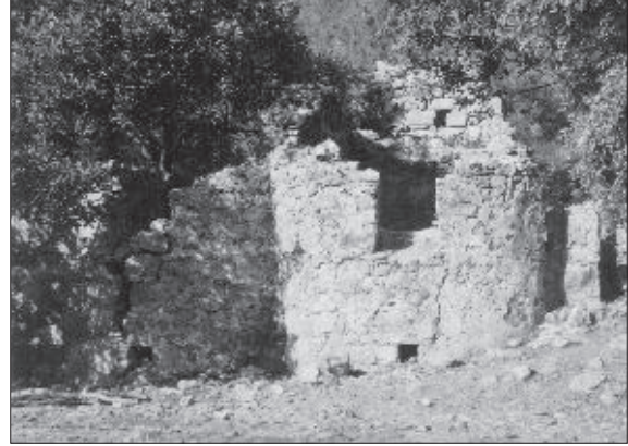
Fig. 12. Terme II, lato absidale. / Ala Kilise, Therma II : Apsisfassade.
