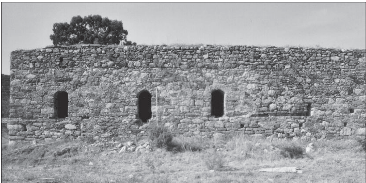
Fig. 2. Gere Kuyu Dere, terme protobizantine, facciata meridionale. / Gere Kuyu Dere, frühbyzantinische Therma , Südfassade.
