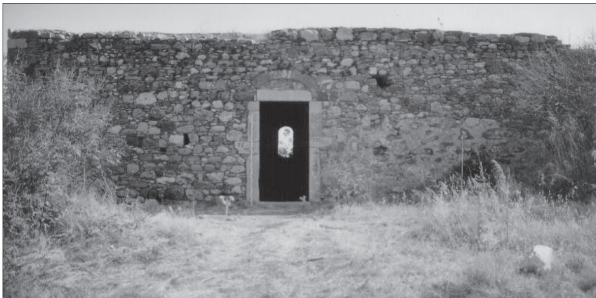
Fig. 4. Terme, facciata settentrionale. / Therme , Nordfassade.
