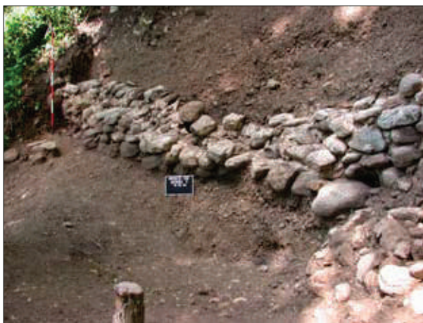
Fig. 1. Muro di contenimento del colle di Santo Spirito, venuto alla luce in seguito ad una frana nel giugno del 1996
