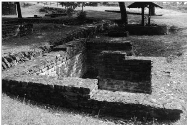
Fig. 4. Les vestiges de constructions d'époque romaine conservés et mis en valeur sur le Titelberg (photo C. Steffes).
