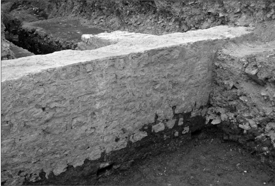
Fig. 4. Particolare della facciata del muro ellittico di sostruzione della cavea (fig. 2.B), a cui si attestava (a destra dell'immagine in alto) uno dei radiali della raggiera esterna (fig. 2.C4) (fotografia di Valeria Grazioli).
