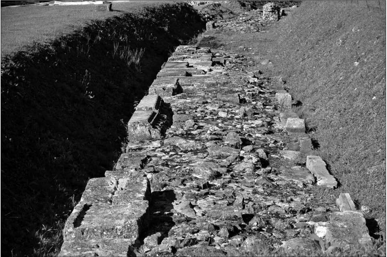
Fig. 24. Il muro interno da est: si osservino in particolare i numerosi frammenti di reimpiego di cui era costituita la cortina (fotografia di Patrizia Basso).
